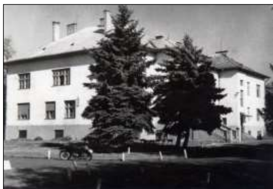
A Nagykastély emeletráépítés előtt és után
