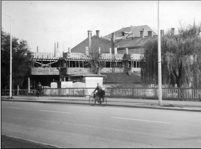
A Lepkeház építkezése
