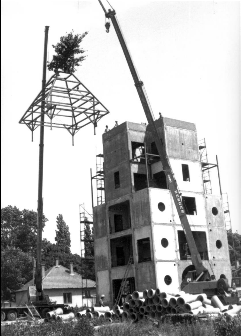
A „Torony” tetőgerendázatának beemelése, Bokrétáünnepélye
