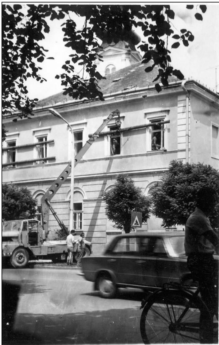
A falakat a sarkokon gerendákkal tartották stabilan a felújítás elkezdéséig
