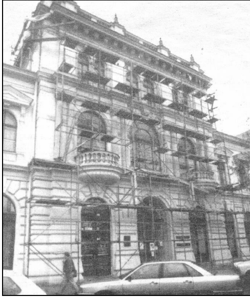
A Bérház homlokzatának felújítása – 1994.
