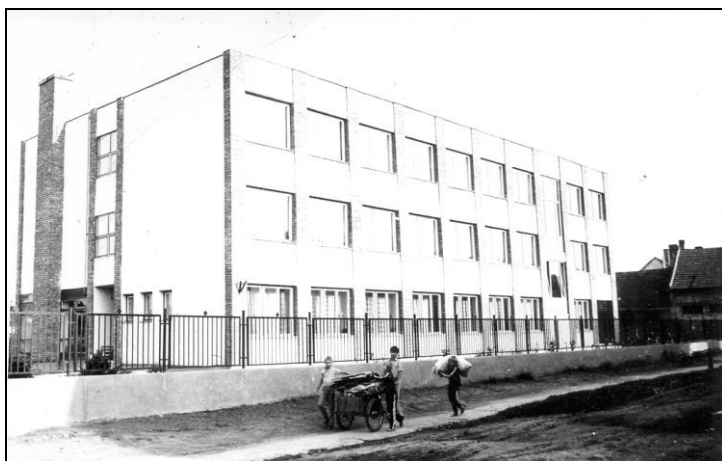
A IV. sz. Általános Iskola és Diákotthon Szánthó utcai épülete az átadás után
